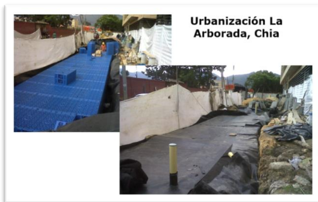
Imagen 6 instalación de las canastillas tipo Aquacell.
