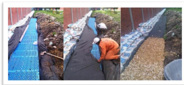
Imagen 5 instalación de las canastillas tipo Aquacell.
