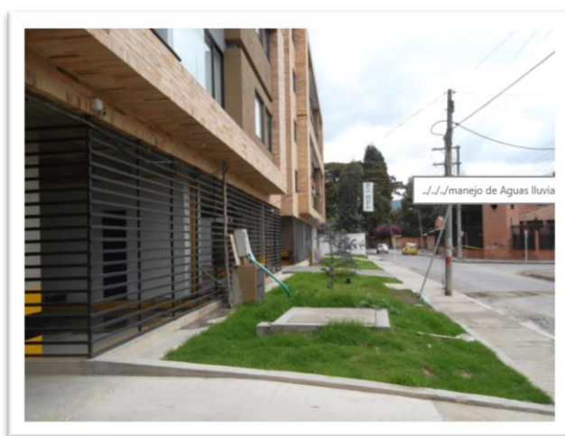
Imagen 7 instalación de las canastillas tipo Aquacell.
