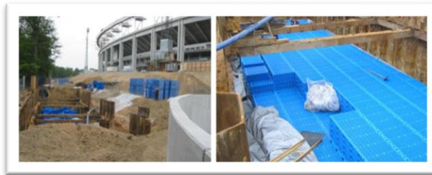
Imagen 4 Construcción de estanque de almacenamiento subterráneo con canastillas de polipropileno tipo Aquacell.
