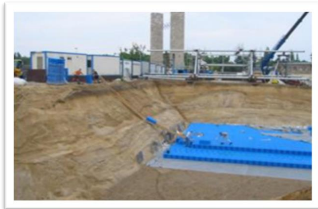
Imagen 3 Implementación de canastilla tipo AQUACELL como estanques para agua de escorrentía. Tomado de Manejo inteligente del agua lluvia.
