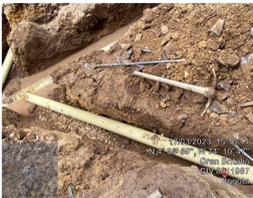
Figura 5. Instalación tubería sanitaria “domiciliaria”
