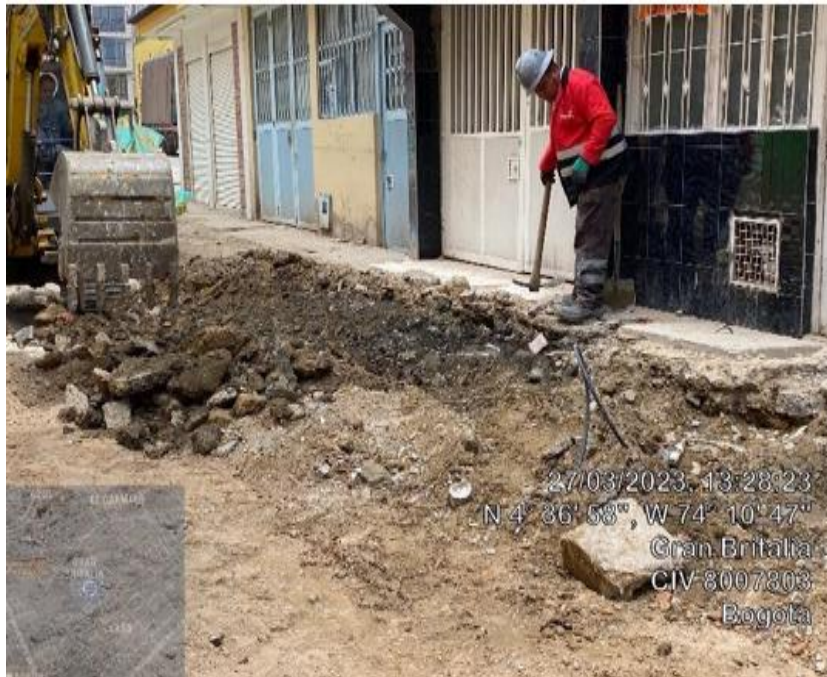
Figura 11. Demolición espacio publico
