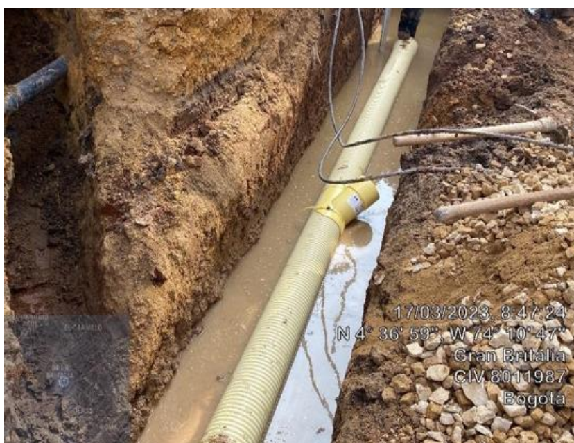
Figura 6. Instalación tubería pluvial
