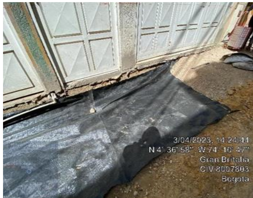
Figura 12. Instalación geotextil espacio publico
