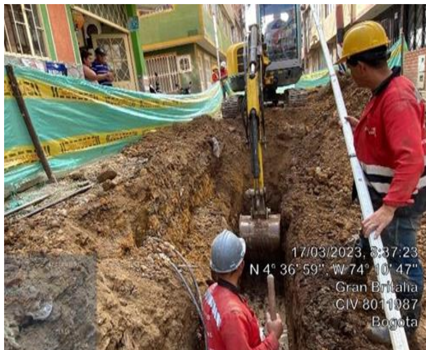
Figura 4. Excavación mecánica
