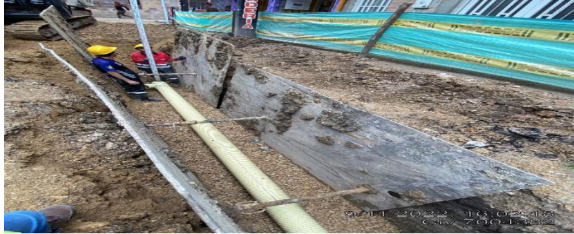
Figura 16. Instalación tubería pluvial
