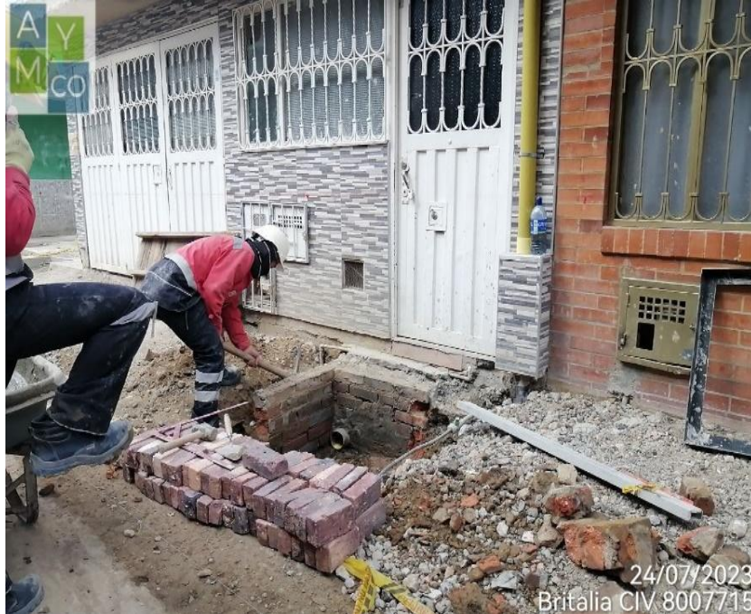
Figura 18. Construcción cajas de inspección
