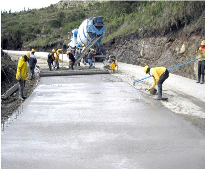
Figura 19. Vaciado de concreto
