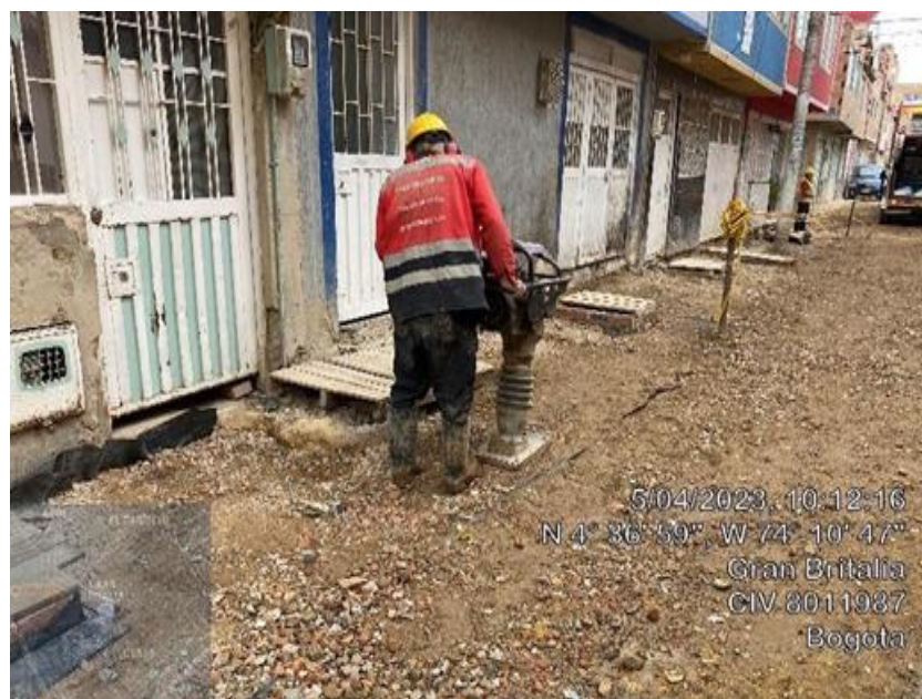
Figura 13. Compactación SBG-R espacio publico
