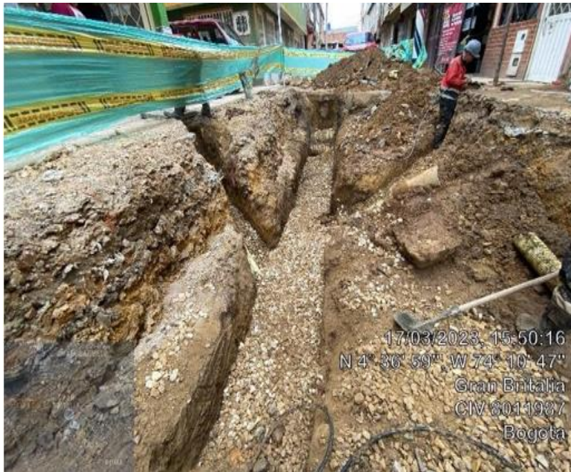
Figura 7. Instalación triturada 3/4
