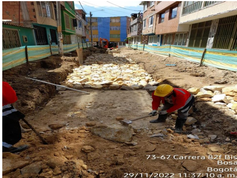
Figura 9. Instalación de rajón
