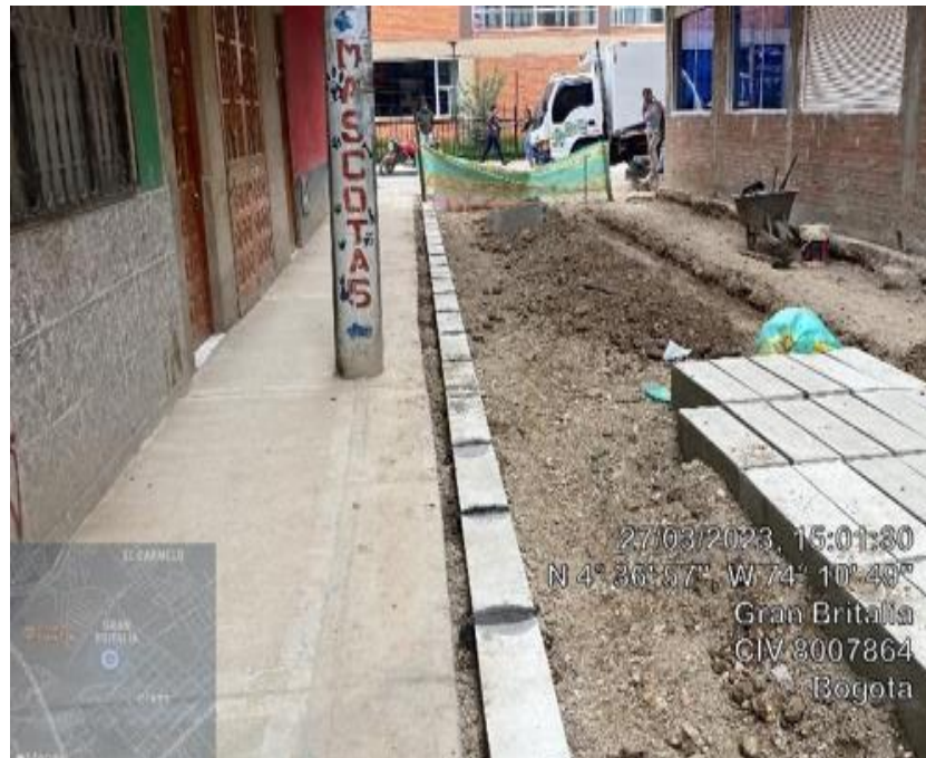
Figura 14. Instalación bordillo A-80
