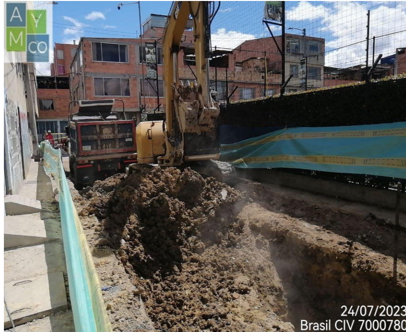
Figura 8. Excavación mecánica “cajeo”
