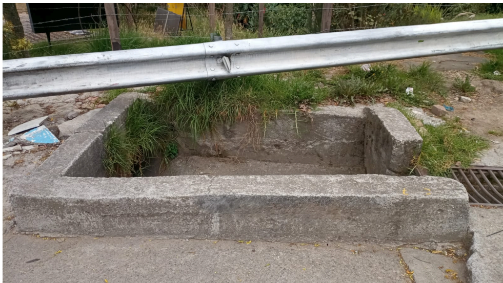
Ilustración 0-6 [Estructuras de alcantarillado existentes (Vía Bogotá-calera)]. Tomada [Fuente Propia] ([2024]).
