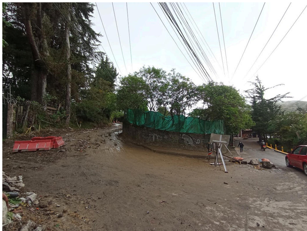
Ilustración 0-9 [Estratigrafía a simple vista (vía calera-Bogotá)]. Tomada [Fuente Propia] ([2024]).
