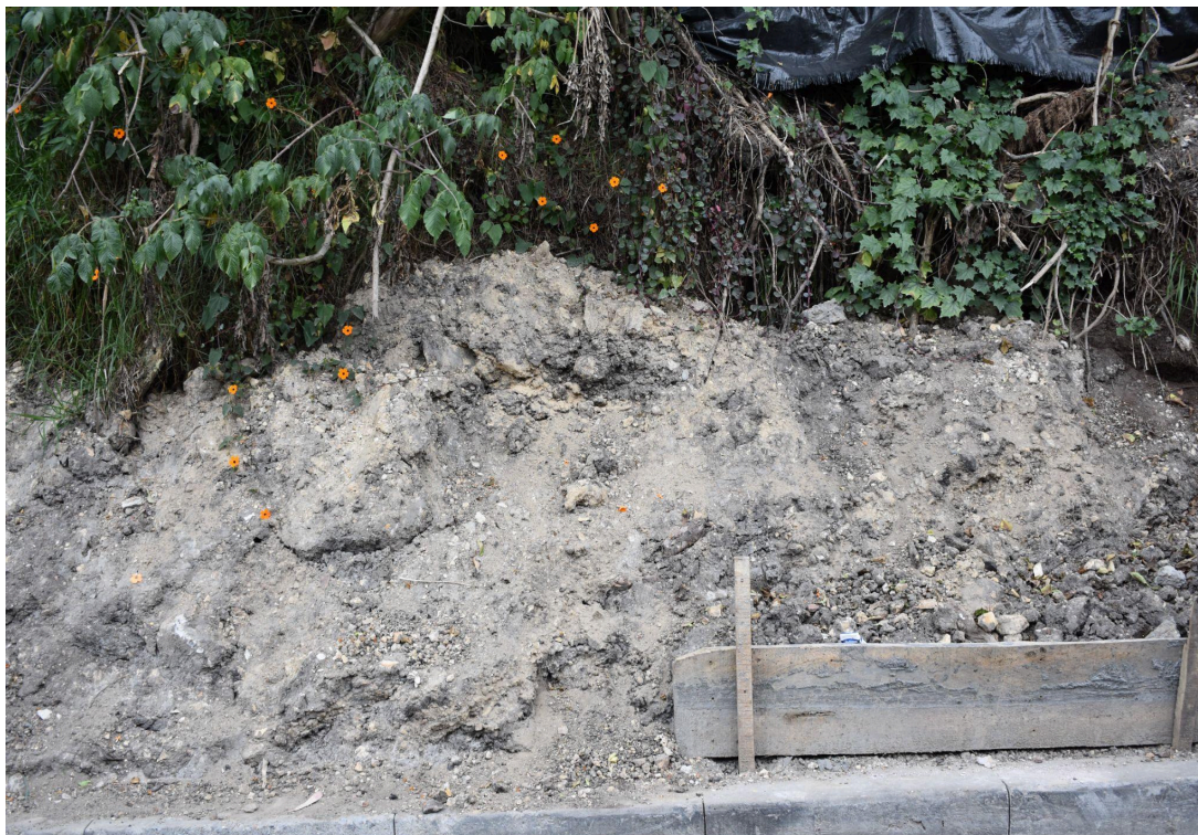
Ilustración 0-8 [Estratigrafía a simple vista (vía calera-bogotá)]. Tomada [Fuente Propia] ([2024]).
