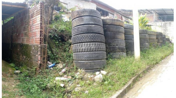
D. DETALLE MURO LLANTAS
