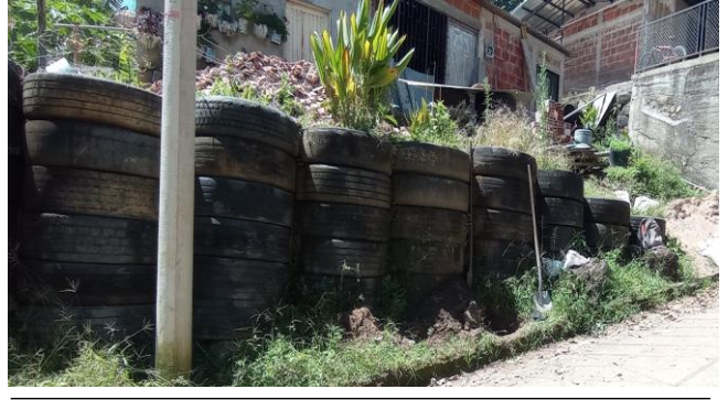
D. DETALLE MURO LLANTAS
