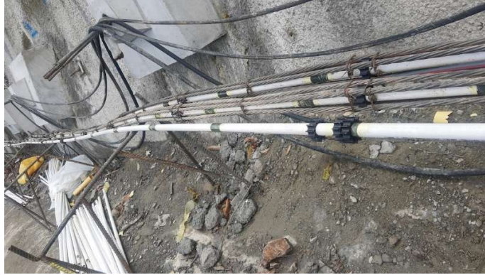
Armado del anclaje antes de su instalación – Fuente: Propia.
