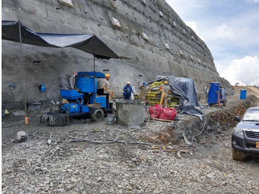
Llenado e inyección de anclajes – Fuente: Propia.
