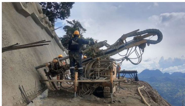
Perforación con Revestimiento – Fuente: Propia
