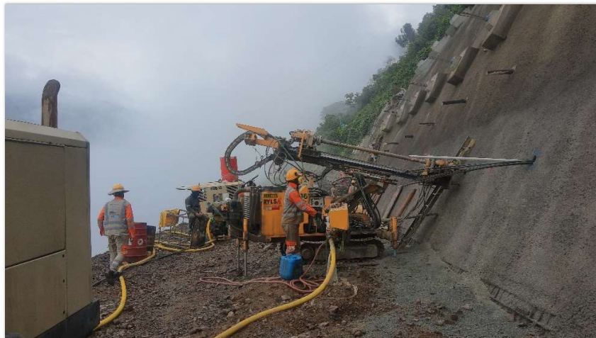
Perforación para instalación de anclajes. Fuente Propia.
