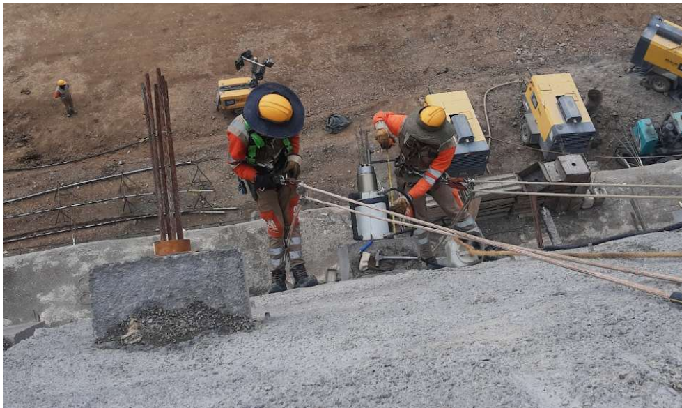
Tensionamientos y Pruebas de Carga. Fuente: Propia.
