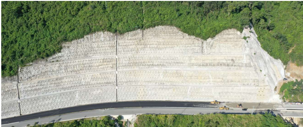
Producto Final construcción Talud TA 9.2. Fuente Propia.
