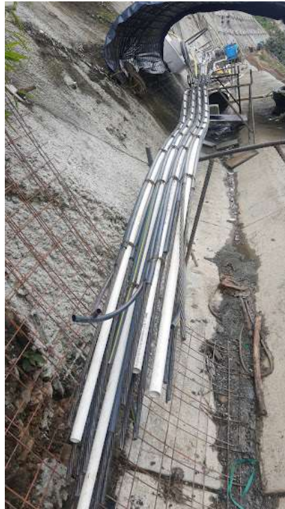
Armado de anclajes según longitud de diseño. Fuente Propia.
