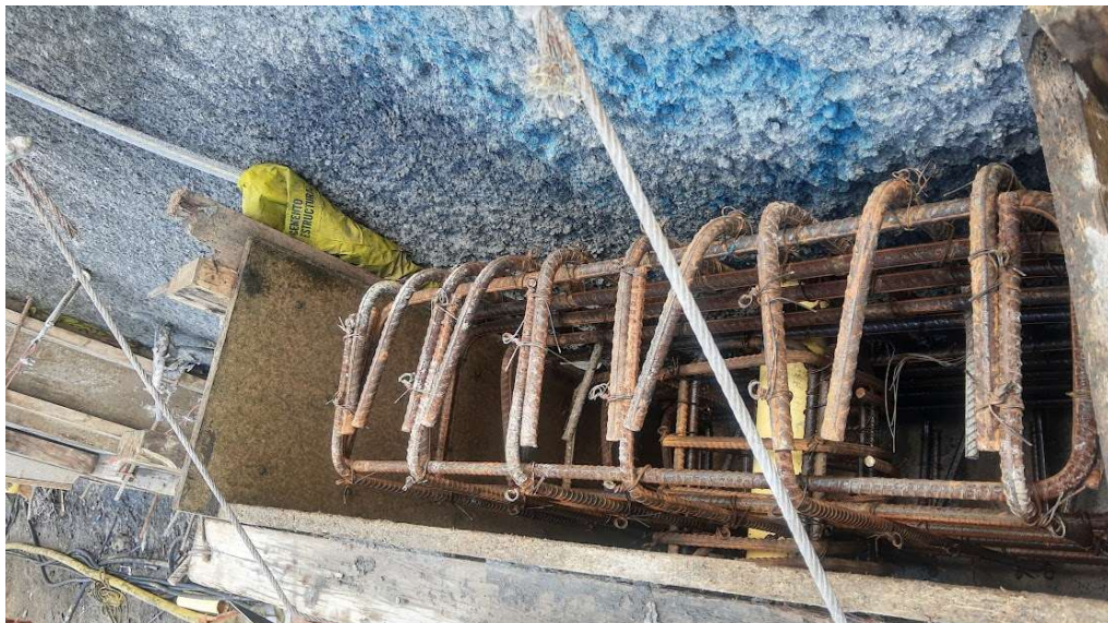
Encofrado de dado de anclaje (cabeza) listo para fundir – Fuente: Propia.
