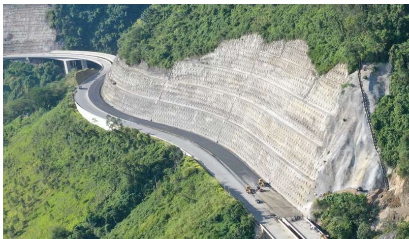
Producto Final construcción Talud TA 9.2. Fuente Propia.
