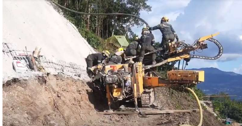
Instalación de anclaje – Fuente: Propia.
