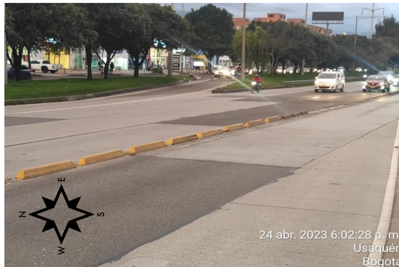
Figura 12. Vista Autopista Norte 151 carriles vehiculares.
