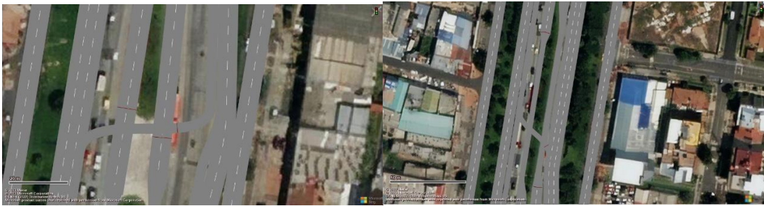
Figura 30. Intersección de intercambio vial en el tramo 1, sentido norte-sur y sur-norte.
