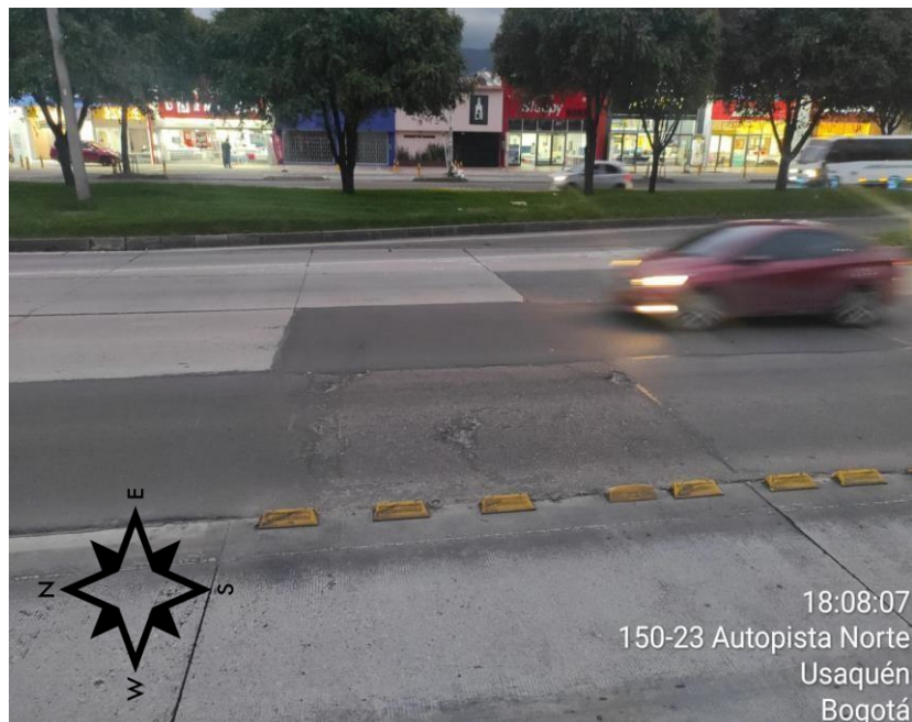
Figura 11. Vista panorámica Autopista Norte con CI 144 sentido norte-sur
