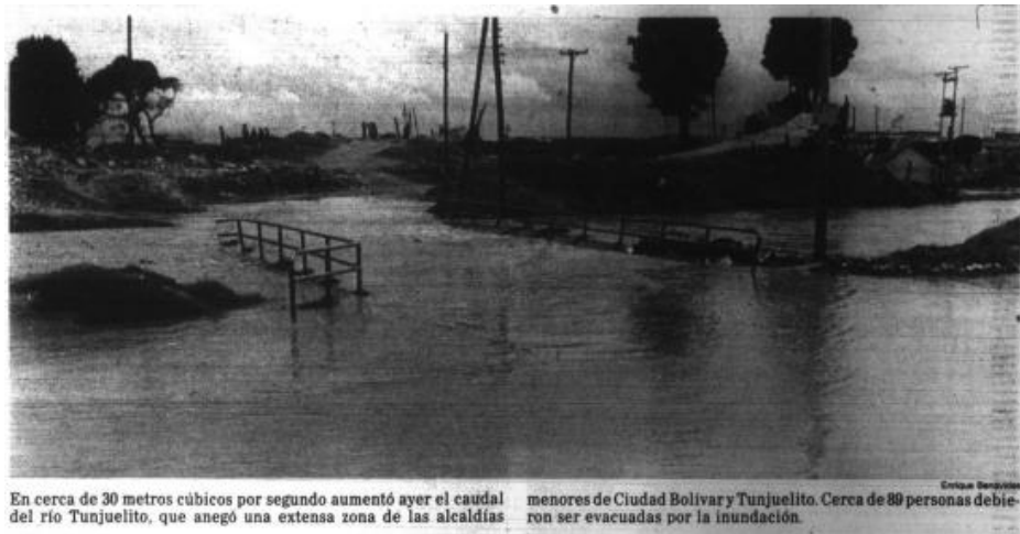
Figura 16 Se temen nuevas inundaciones por río Tunjuelito.
