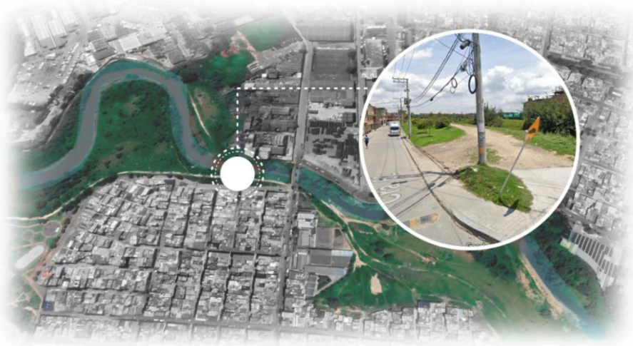
Figura 12 Tramo 2 está ubicado en la localidad de Tunjuelito, UPZ Venecia, barrio Isla del Sol.
