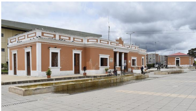
Estación de ferrocarril de Cajicá
