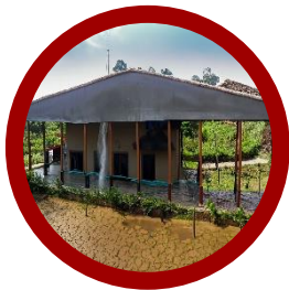
1. NIVEL FREÁTICO ALTO
