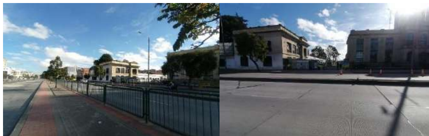
figura 28 estación de seguridad
