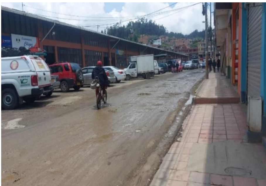
Figura 20 problemática deterioro malla vial plaza de mercado
