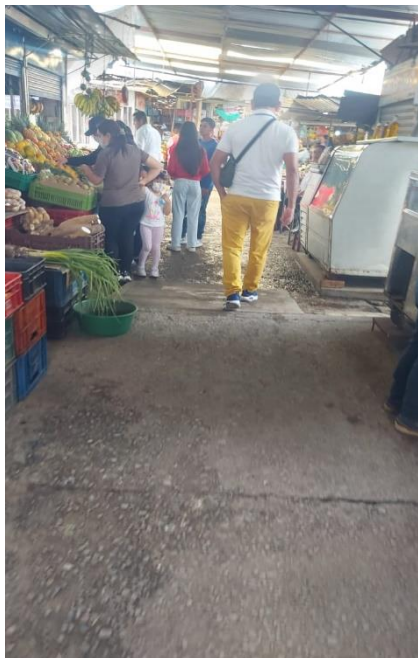
Figura 36 deterioro del centro de abastecimiento
