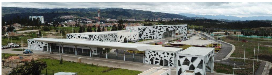
Terminal de transporte de Tunja
