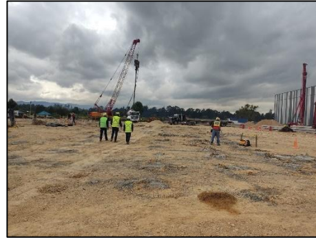
Figura 36 Replanteo de pilotes Fuente: propia
