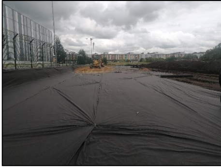
Figura 56 Geotextil Fuente propia
