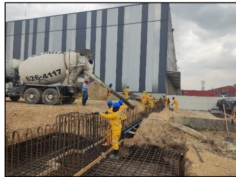
Figura 119 Muro de contención Fuente propia
