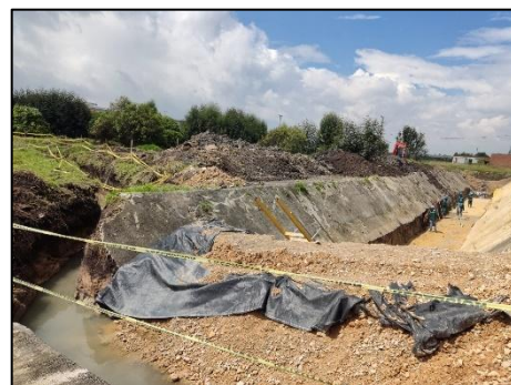
Figura 102 Construcción de Box Culvert Fuente propia
