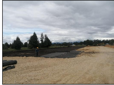
Figura 57 Geotextil Fuente propia
