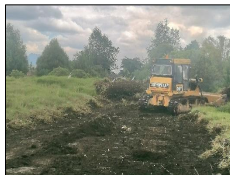
Figura 43 Descapote Fuente. Propia
