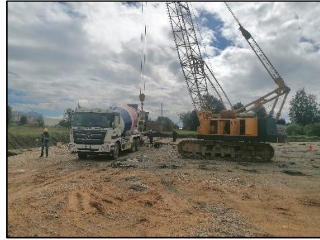
Figura 76 Inclusiones rígidas Fuente propia
