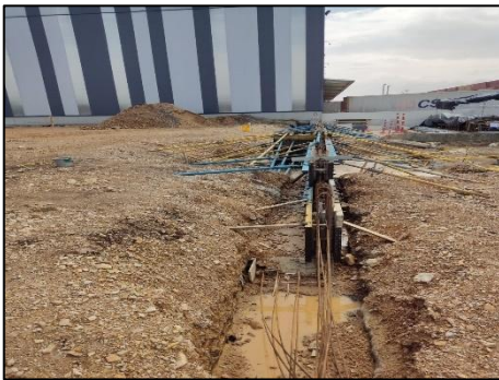
Figura 118 Muro de contención Fuente propia
