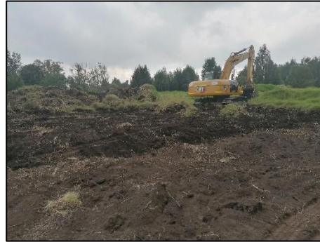
Figura 47 Nivelación de terreno Fuente. Propia
