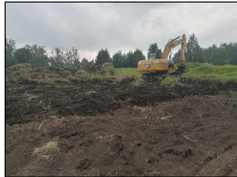
Figura 14 Retroexcavadora Fuente: propia
