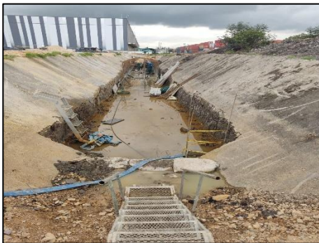
Figura 99 Construcción de Box Culvert Fuente propia
