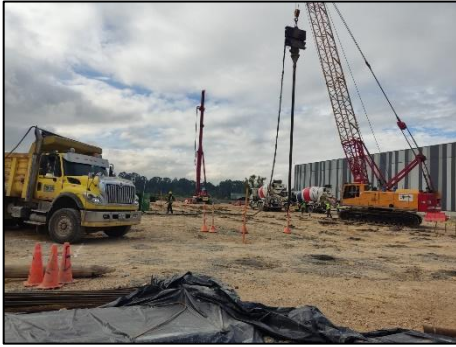
Figura 112 pilotes fundidos Fuente propia
