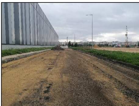
Figura 52 Aprovechamiento de material proveniente de excavación Fuente propia
