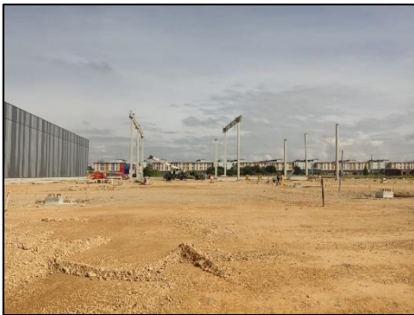
Figura 114 Izaje de vigas y columnas Fuente propia
