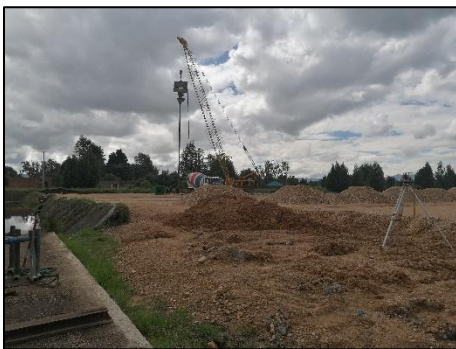
Figura 15 Piloteadora Fuente: propia
