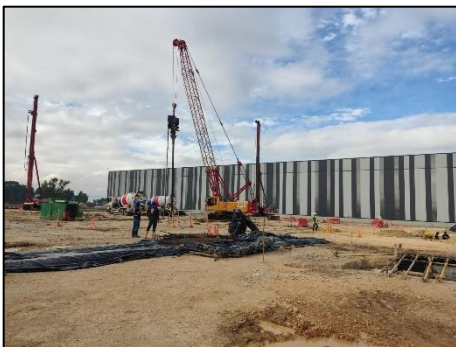
Figura 108 pilotes fundidos Fuente propia
