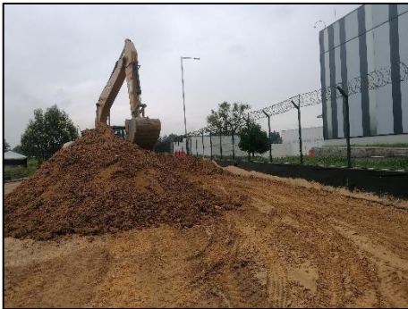
Figura 13 Retroexcavadora Fuente: propia
