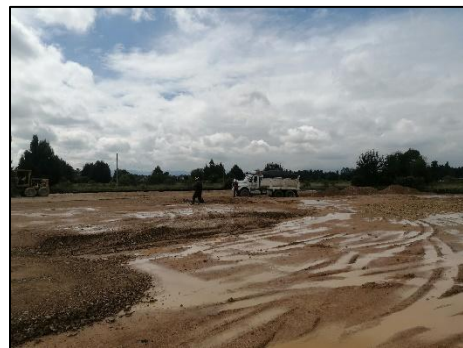
Figura 66 Obras de mitigación Fuente propia
