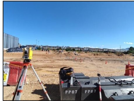
Figura 38 Replanteo inclusiones rígidas Fuente: propia
