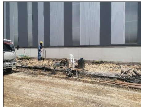
Figura 34 Replanteo de ejes Fuente: propia
