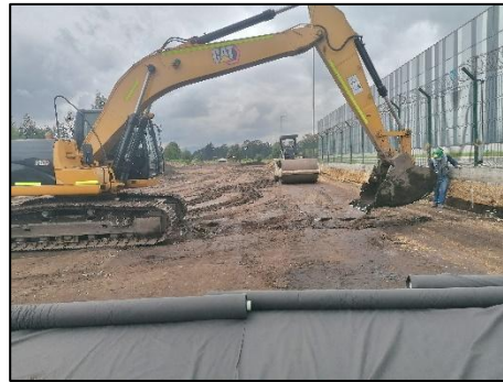
Figura 49 Nivelación de terreno Fuente. Propia
