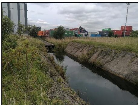
Figura 97 Construcción de Box Culvert Fuente propia
