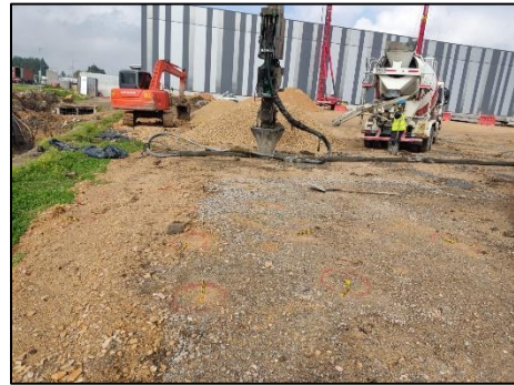
Figura 107 pilotes fundidos Fuente propia
