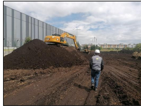
Figura 51 Aprovechamiento de material proveniente de excavación Fuente propia
