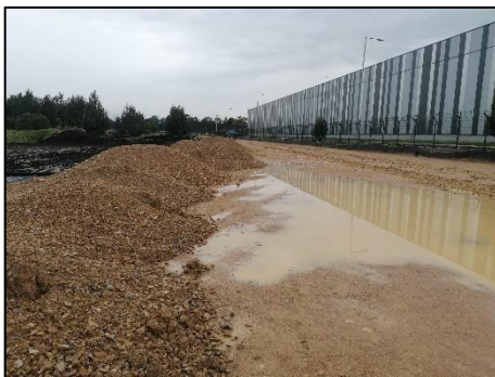
Figura 65 Obras de mitigación Fuente propia
