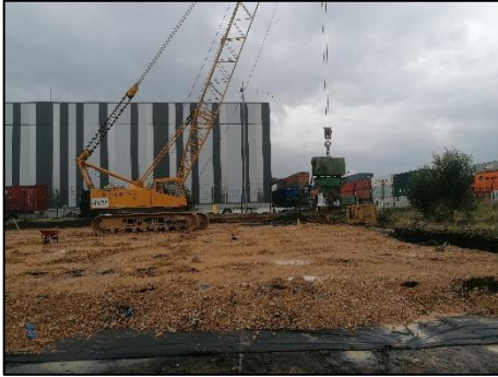
Figura 69 Inclusiones rígidas Fuente propia
