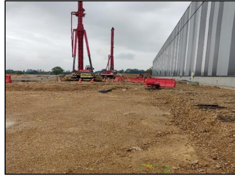
Figura 113 pilotes fundidos Fuente propia
