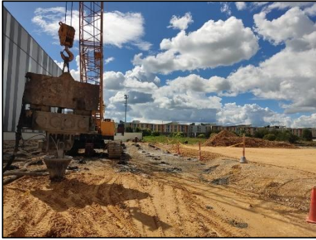
Figura 75 Inclusiones rígidas Fuente propia
