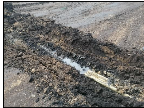
Figura 55 Fallos Fuente propia
