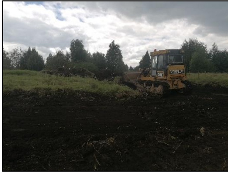
Figura 17 Bulldozer Fuente: propia
