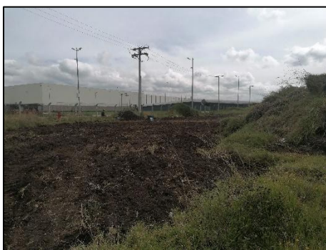
Figura 42 Descapote Fuente. Propia
