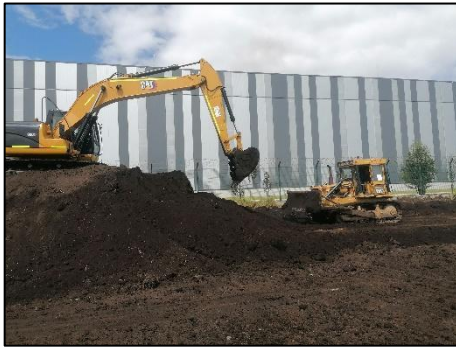
Figura 50 Aprovechamiento de material proveniente de excavación Fuente propia
