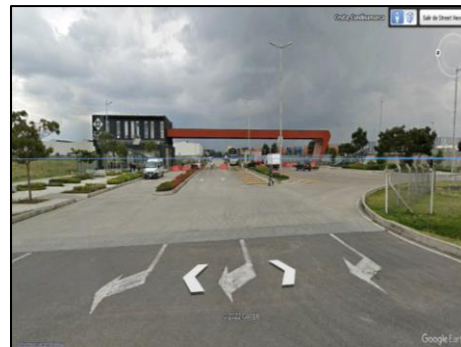
Figura 6 Entrada del proyecto Fuente Google Earth
