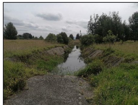
Figura 98 Construcción de Box Culvert Fuente propia
