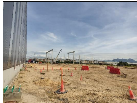
Figura 115 Izaje de vigas y columnas Fuente propia
