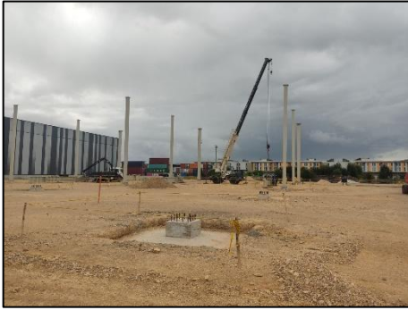
Figura 116 Izaje de vigas y columnas Fuente propia
