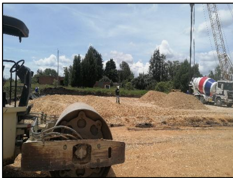
Figura 19 Vibrocompactador Fuente: propia
