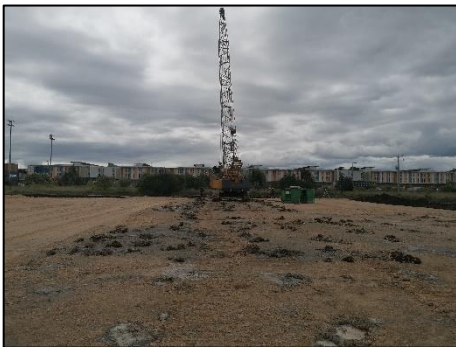
Figura 69 Inclusiones rígidas Fuente propia
