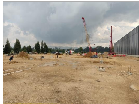
Figura 109 pilotes fundidos Fuente propia
