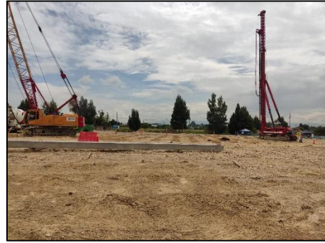
Figura 117 Izaje de vigas y columnas Fuente propia
