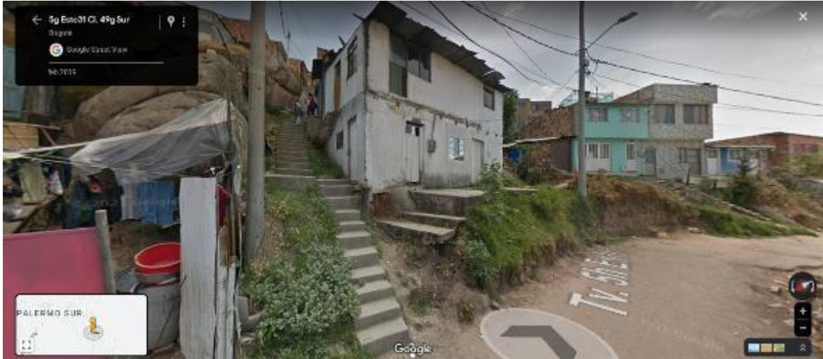
Figura 20. vivienda en zona de riesgo UPZ 55.
