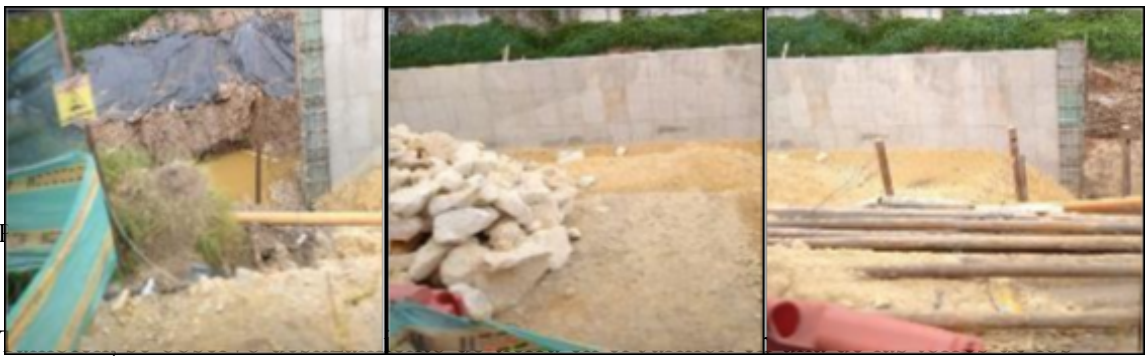
Figura 14. Obra mitigación deslizamientos costado oriente del barrio hacienda los molinos UPZ 54.
