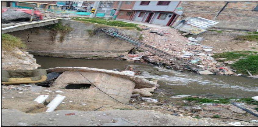
Figura 37. Deslizamientos en la ronda de la quebrada la Chiguaza
