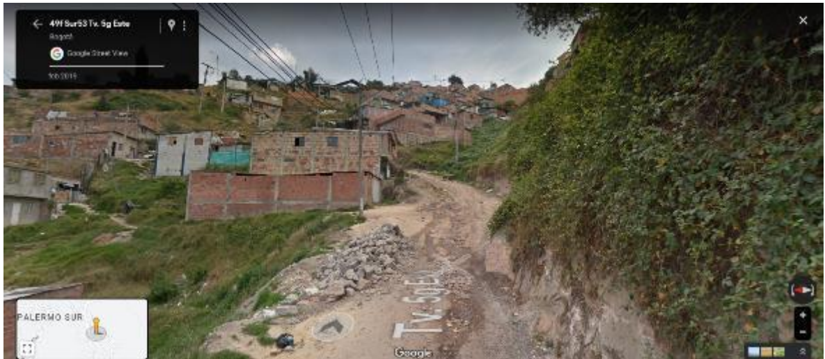
Figura 33. Aguas residuales Barrio Nueva Esperanza
