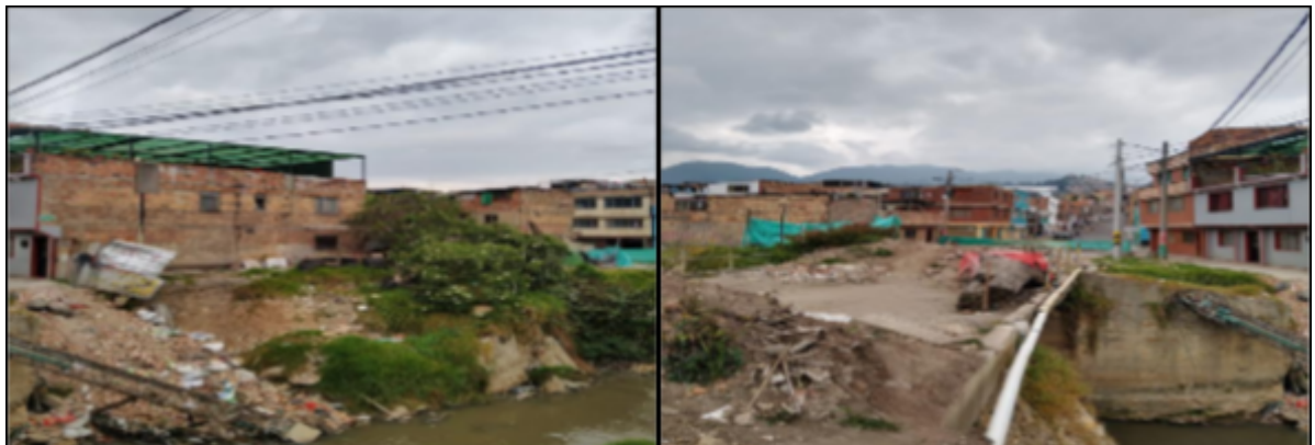
Figura 13. Deslizamientos de tierra en los bordes de la quebrada la Chiguaza UPZ 54
