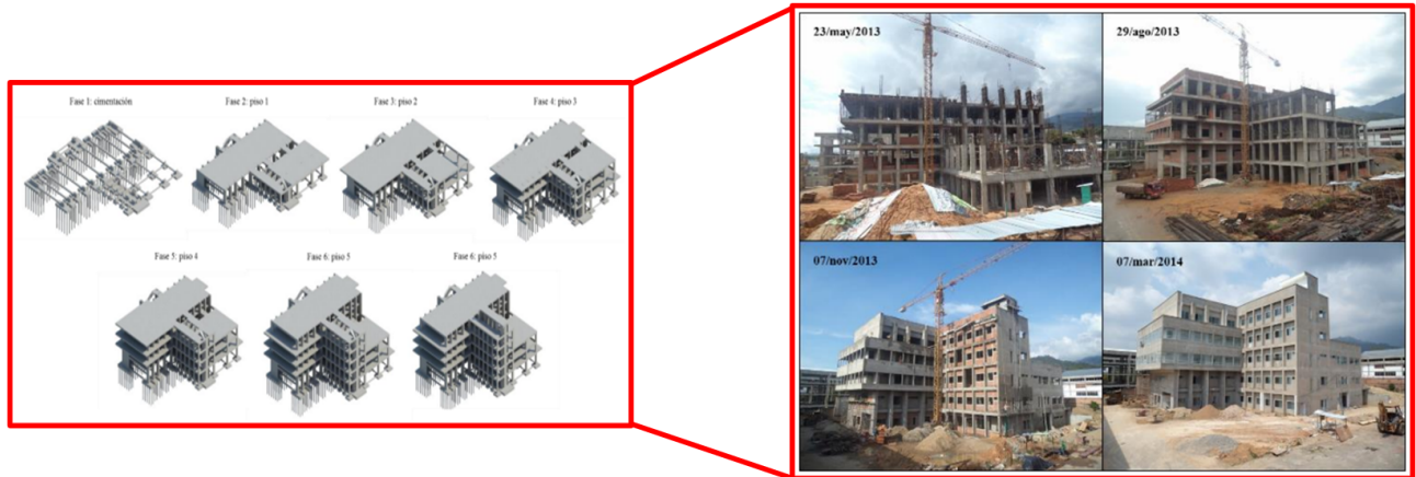
Figura 2. Diseño y modelo estructural en Revit con seguimiento en obra.
