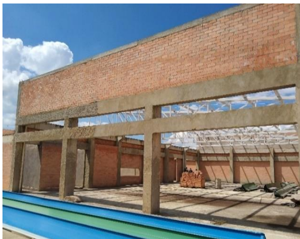
Figura 15 Bloque G – Fachada frontal
