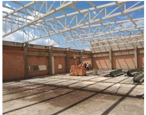
Figura 16 Bloque G - Estructura Metálica del Centro de recursos
