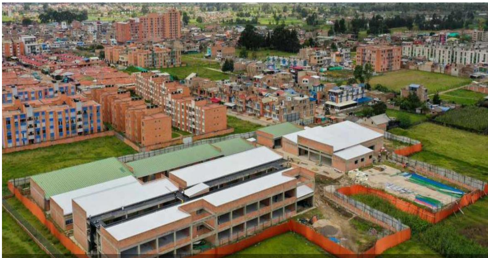
Figura 39 Recepción de obra terminada
