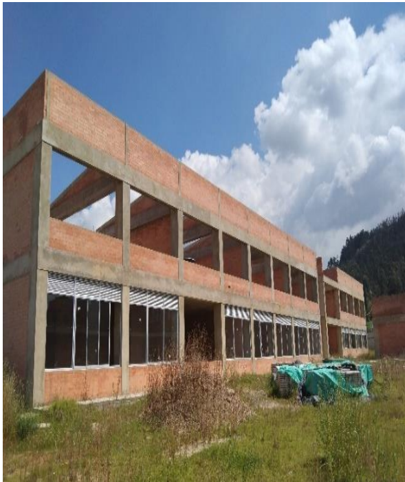
Figura 13 Bloque F – Fachada frontal
