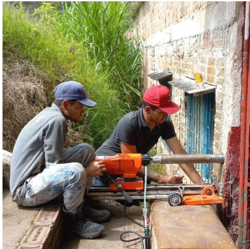
Figura 31. Extracción de núcleo en columna del edificio C.
