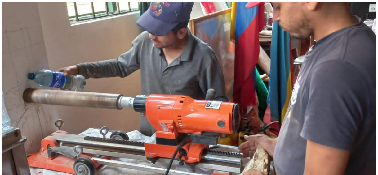
Figura 33. Extracción de núcleo en columna del edificio D.
