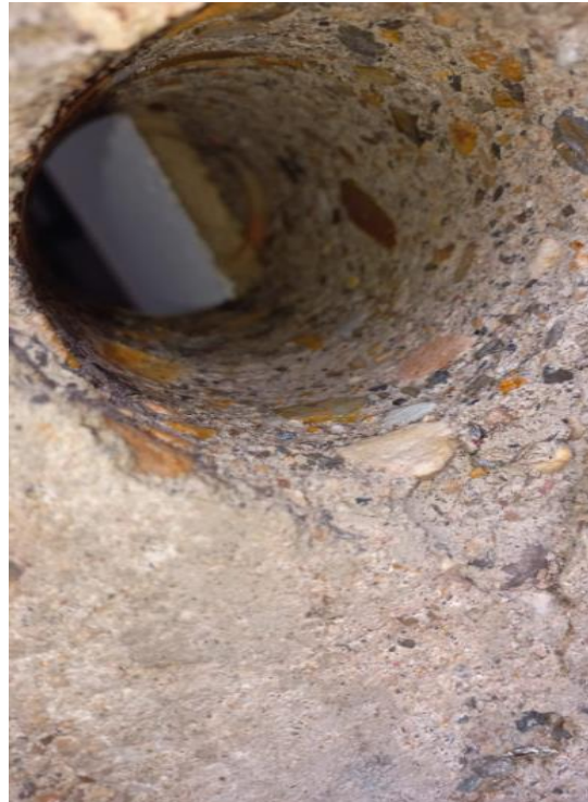
Figura 15. Ensayo de carbonatación edificio C.
