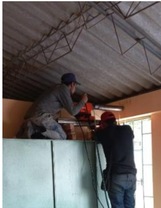
Figura 32. Extracción de núcleo en viga del edificio D.
