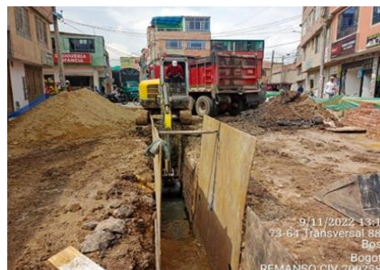
Ilustración 10 Instalación de entibado metálico para excavaciones con más de 0.9m de profundidad.
