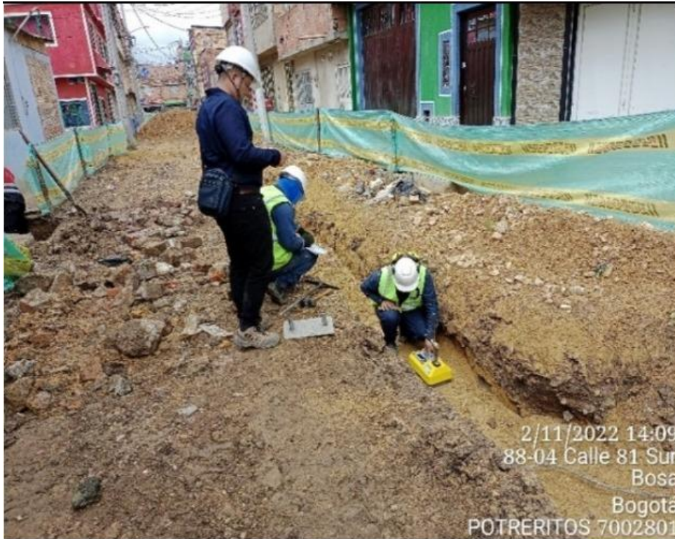
Ilustración 5 Toma de densidades sobre recebo común compactado. Barrio Potreritos. PIC
