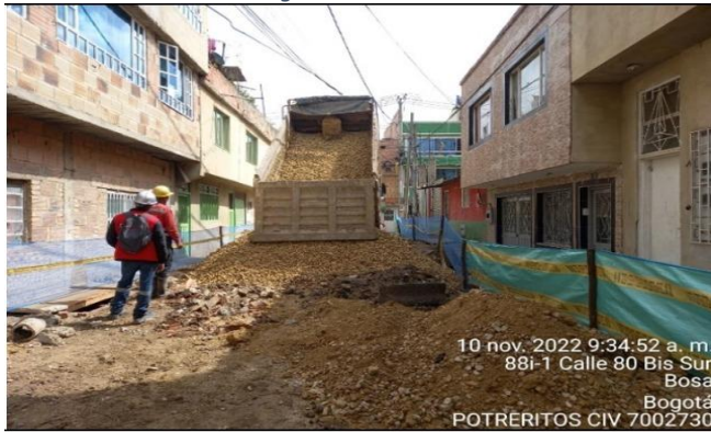
Ilustración 16 Ingreso de material a obra. CIV 7002730
