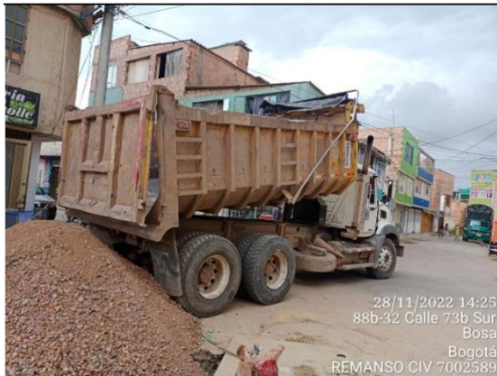
Ilustración 6 Control de material entrante a obra. CIV7002589
