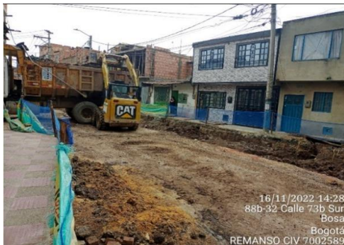
Ilustración 7 Cargue de material proveniente de excavación mecánica
