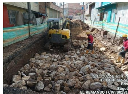
Ilustración 9 Mejoramiento de subrasante con piedra rajón. CIV 7002819
