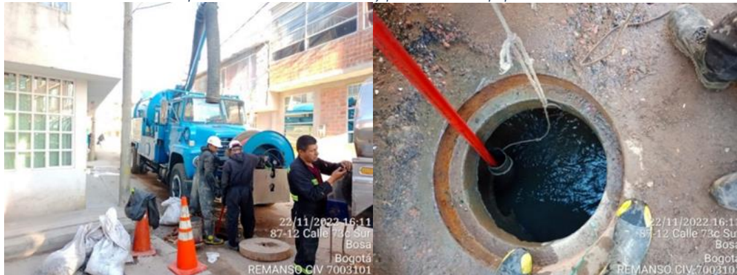
Ilustración 17 Limpieza de tuberías sanitarias y pluviales con equipo vactor. CIV 7002730.
