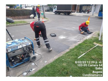
*Nota*. La figura muestra a la cuadrilla aplicando el imprimante con rodillo según el área de referencia anteriormente delimitada. Elaboración propia.
