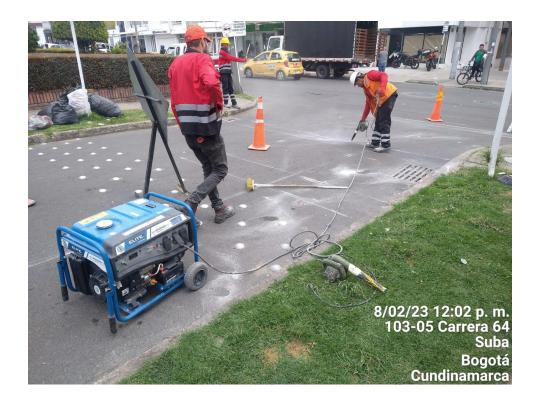
Nota. La figura muestra a la cuadrilla limpiando la zona con una sopladora, esto se puede realizar de igual forma con una escoba. Elaboración propia
