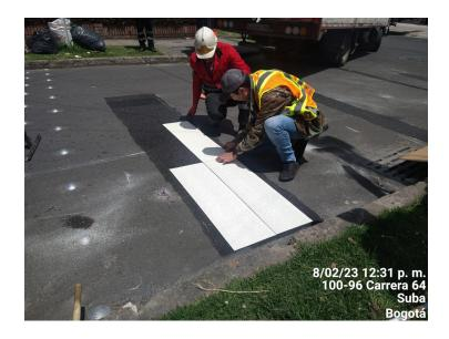
*Nota*. La figura muestra como el ingeniero proveedor de la cinta, capacita a la cuadrilla, indicando la forma en la que se debe armar la figura para que esta quede bien instalada. Elaboración propia.
