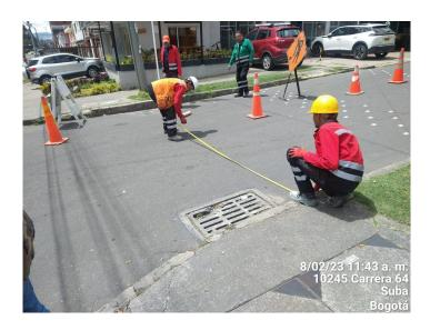
Nota. La figura muestra a la cuadrilla realizando el premarcado para aplicar el imprimante.
