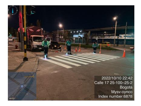
*Nota.* En la figura se puede observar al personal encargado aplicando calor a la cinta termo preformada para un paso peatonal. Elaboración propia.
