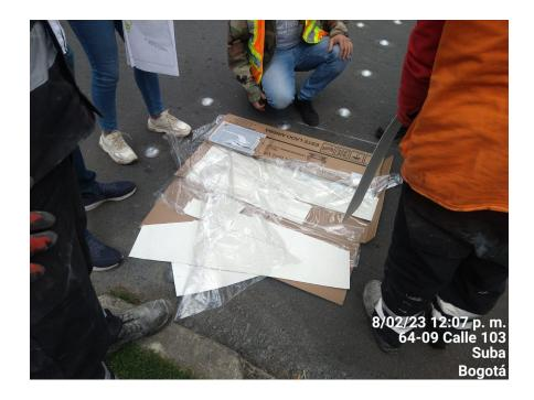
*Nota*. La figura muestra como el ingeniero proveedor de la cinta, capacita a la cuadrilla, indicando la forma en la que se debe sacar las partes que conforman la flecha para poder instalarla. Elaboración propia.
