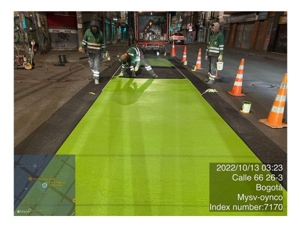
*Nota*. En la figura se puede observar al personal encargado aplicando la pintura llana de un bicicarril. Elaboración propia.
