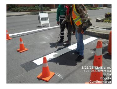
*Nota*. La figura muestra como el ingeniero proveedor de la cinta, capacita a la cuadrilla, indicando la forma en la que se debe aplicar la calor sobre la cinta. Elaboración propia.
