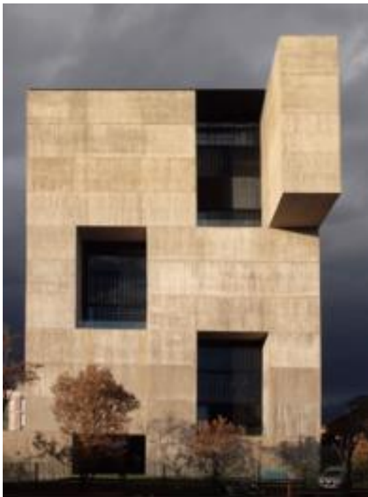
Fachada general Centro de Innovación
