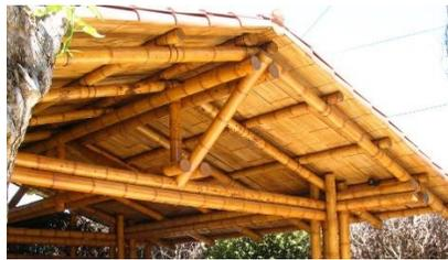
*Nota:* la estructura en guadua será usado a manera de correa o apoyos y se destina en sección doble. Tomado de “Boards y Beams”. 2021. (<https://www.woodboardsandbeams.com/bamboo>).
