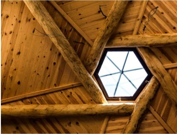
*Nota.* Casa de Fardos de Paja en la ciudad de Guijón, Asturias, 2015. Construcción ecológica con estructura de cubierta recíproca en madera. Tomado de “CUBIERTA RECÍPROCA” M. Fresno. 2015.
