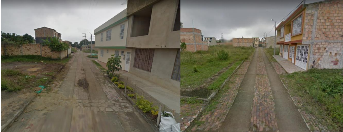
Figura 36. Estado de andenes.
