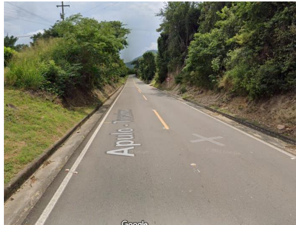
Figura 25. Estado vial Tena – La Mesa Esta vía se encuentra pavimentada, consta de dos carriles de doble sentido, está en buenas condiciones. Tomado de: Google Street view.
