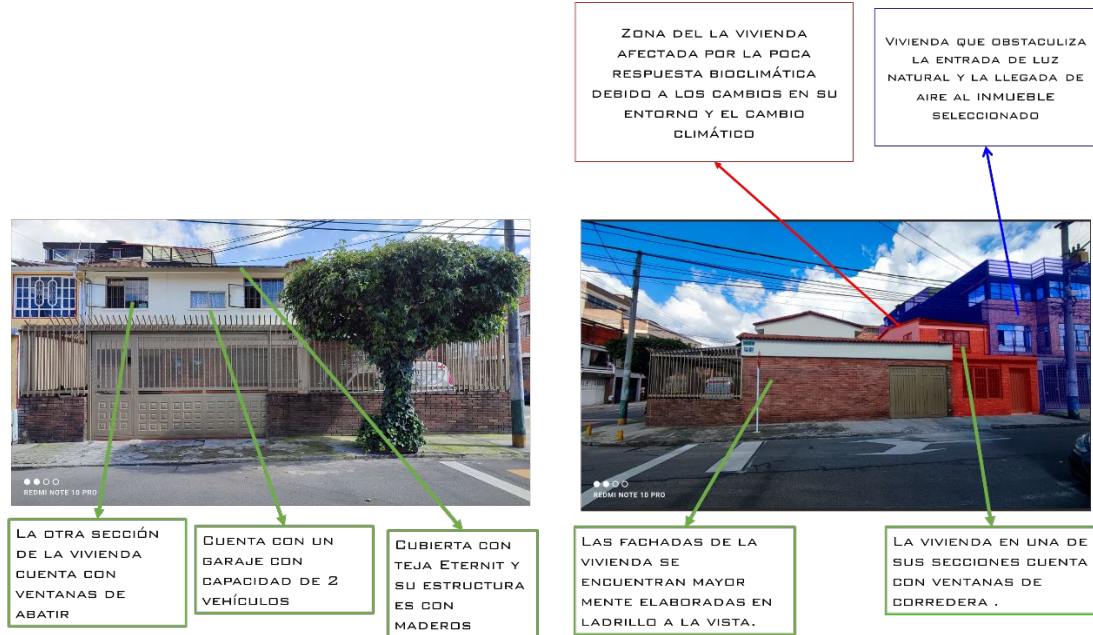
Figura 30 Estado actual de la vivienda
