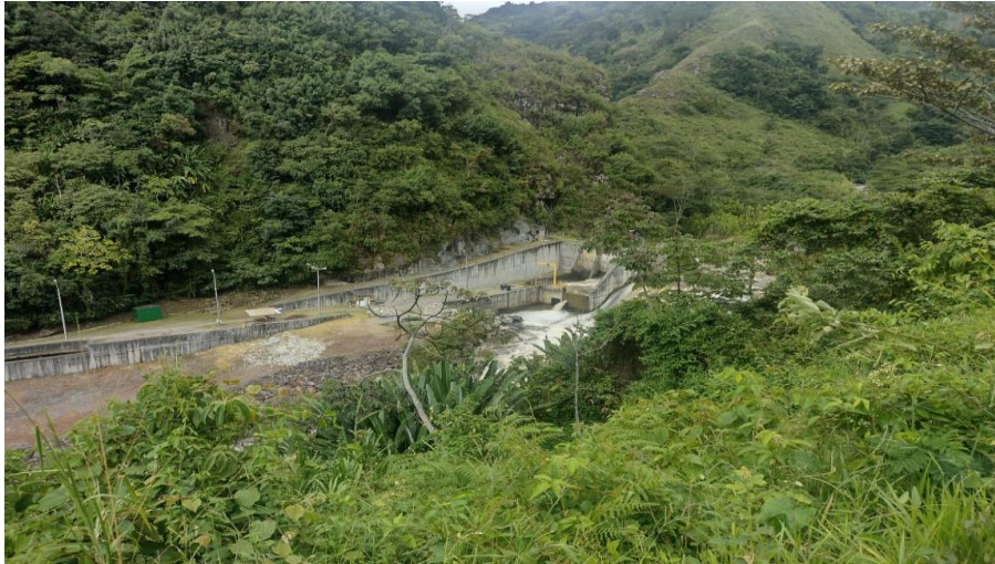
Hidroeléctrico río Amoyá
