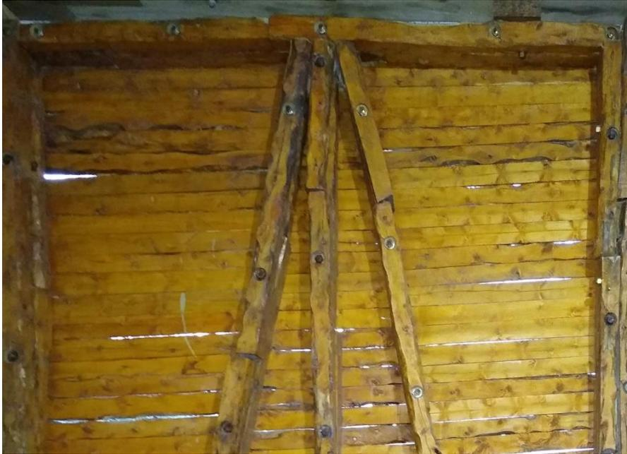
*Nota.* La fotografía refleja la construcción modular de los paneles, cara interna. Elaboración propia.
