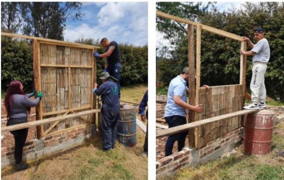
Figura 76 Montaje de marcos.
