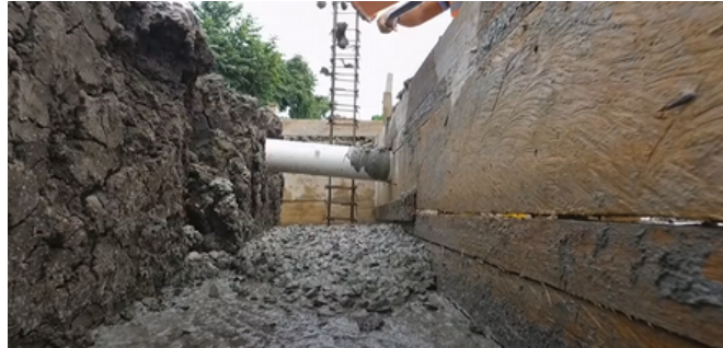
Figura 10. Ejemplo de colocación y distribución del concreto de limpieza.
