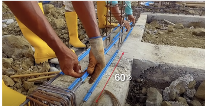
Figura 17. Colocación y amarre de traslapos.
