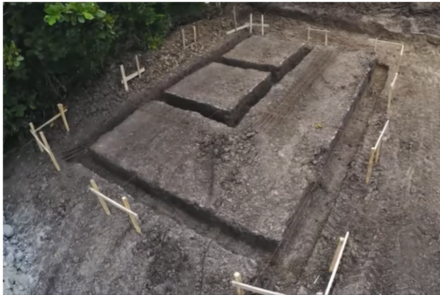
Figura 9. Excavación manual de zanjas.
