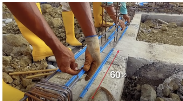
Figura 27. Colocación y amarre de traslapos.
