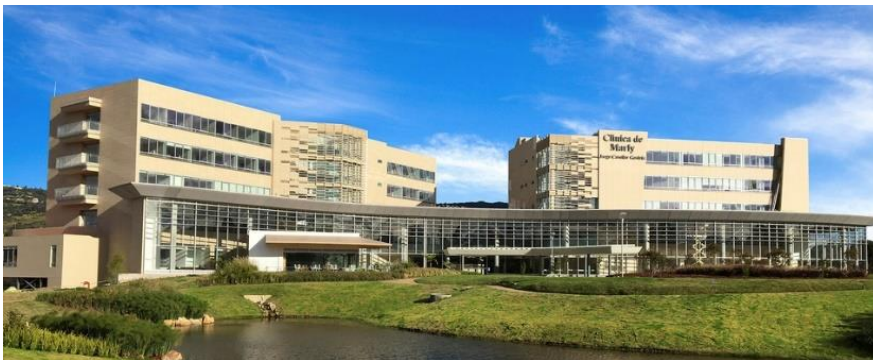
Fachada principal Clínica Marly Jorge Cavelier Gaviria
