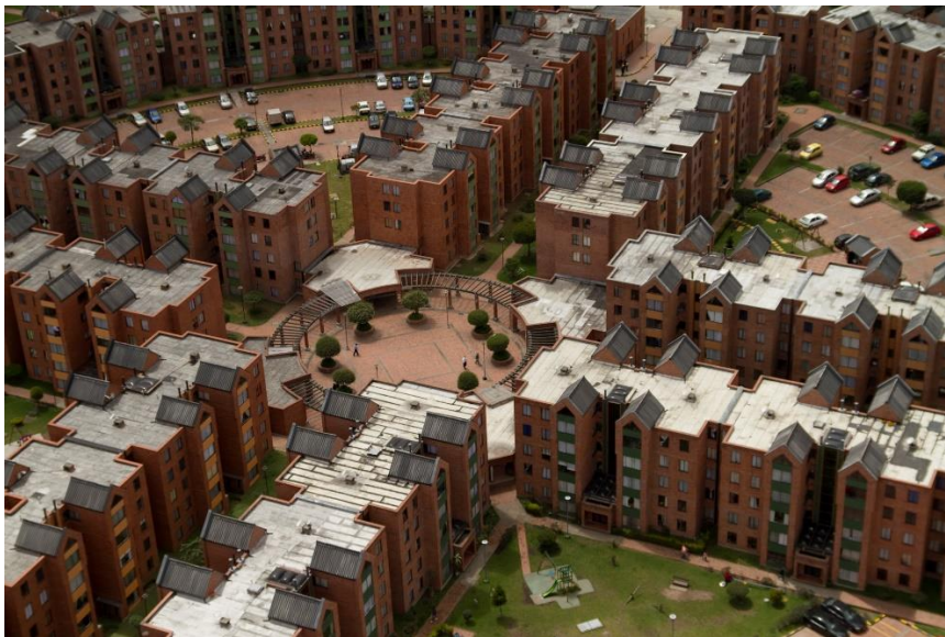
Figura 10. Repetición modulada de formas en las unidades de vivienda de la Ciudadela Colsubsidio.
