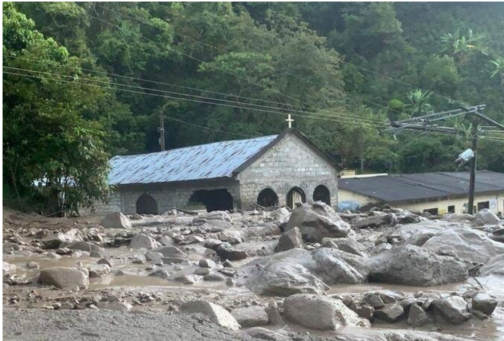
Figura 8. Pérdida infraestructural por desbordamiento de la quebrada El Mono
