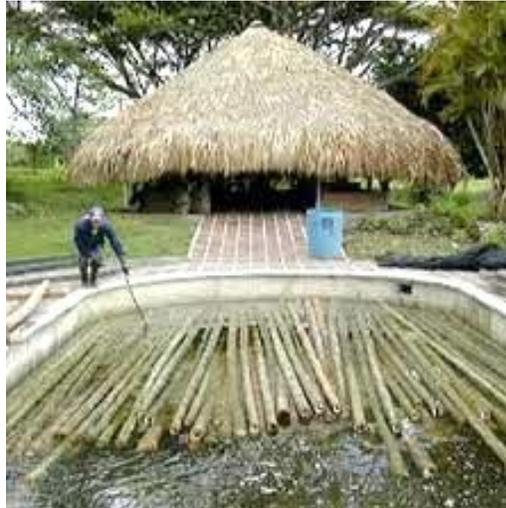
*Nota.* El grafico representa el curado que se le realiza al bambú después de cortado se realiza en agua, es un buen curado para construcciones en regiones rurales. Tomado de. “Manual de la construcción de estructuras con bambú”, Por servicio de capacitación para la industria de la construcción- SENCICO, 2014
