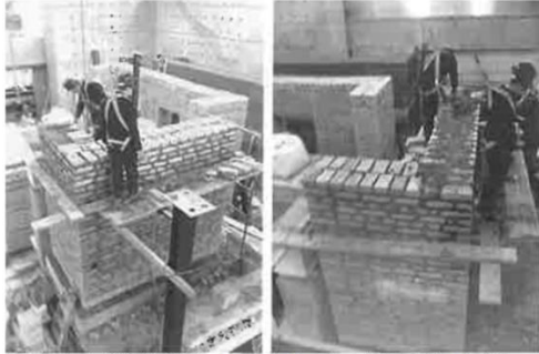
Fuente: Investigación IDPC - AIS (2015) Proceso constructivo de especímenes de adobe, en Laboratorio de Estructuras Uniaxiales, para ensayo en mesa vibratoria.
