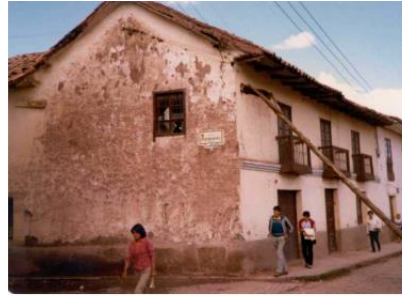
Foto 1. Inicio de la grieta en la parte superior del tímpano, Cuzco 1985. Foto: D. Torrealva
