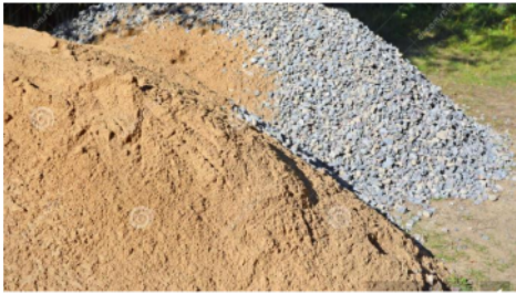
Figura 6. Agregados (arena y piedra)
