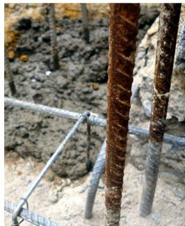
4. Luego se introduce una varilla de  $\frac{3}{4}$  en el centro con una cinta de seguridad indicando el sitio exacto.
