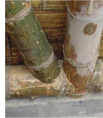
Moldeado pico de flauta y aplicación
