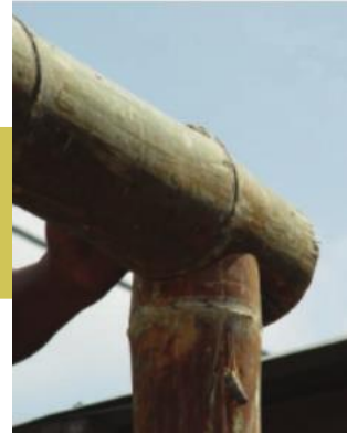
Moldeado boca de pescado y aplicación
