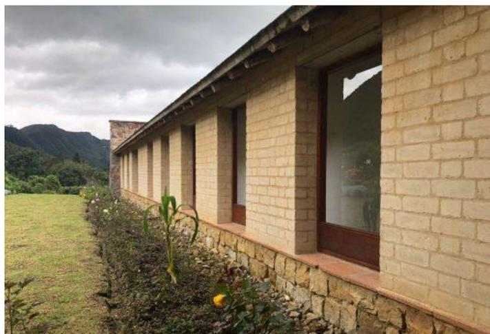
*Nota.* Imagen de un proyecto de vivienda realizado con bloques de tierra compactada. Tomado de “Tierratec”, 2021.
