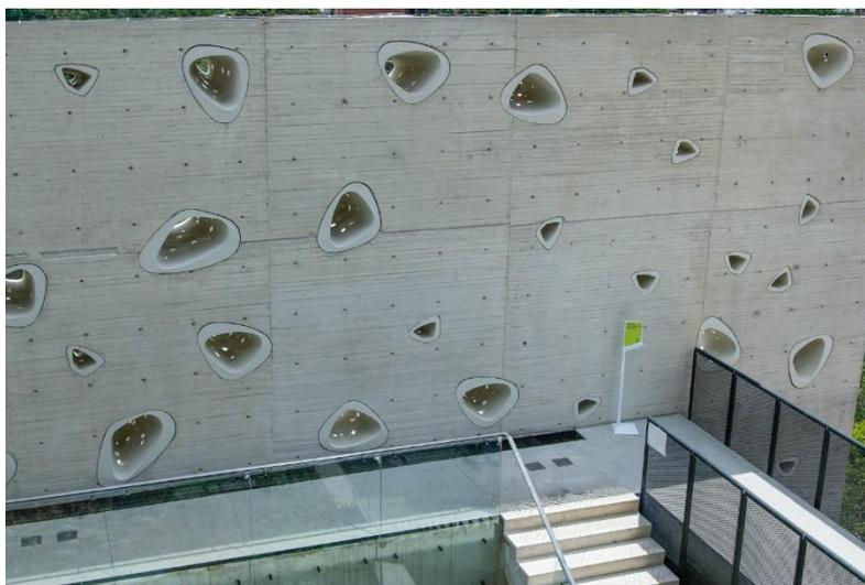
*Nota.* Imagen de un acabado en concreto arquitectónico. Tomado de “Argos”, 2021. (<https://bit.ly/3FsJ9yM>)
