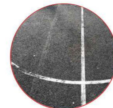
suelo asfáltico para canchas
