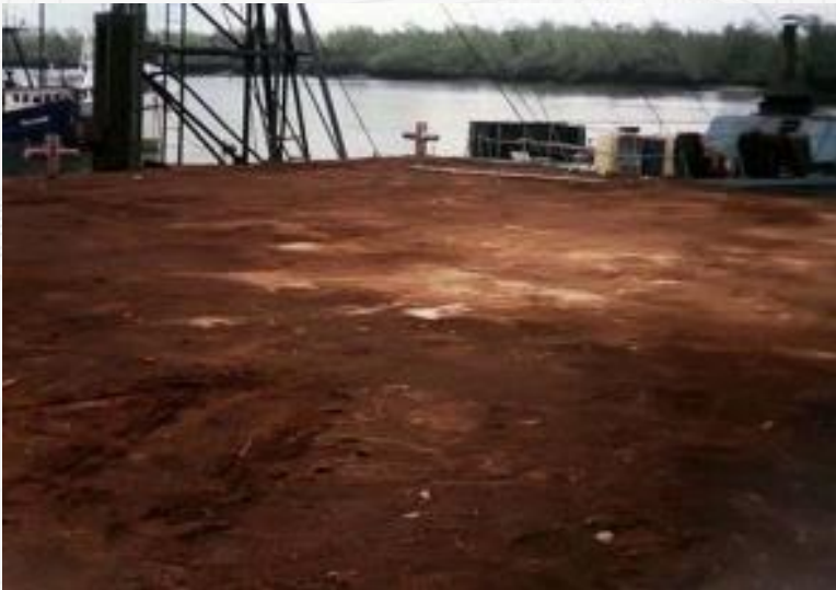
Figura 6. Muelle fundido y curado con aserrín. https://bit.ly/2Uy6Pvt
