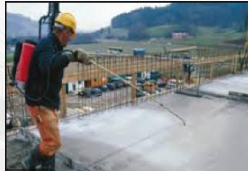
Figura 2. Rocio de placa con Antisol rojo. https://bit.ly/2IBauq6
