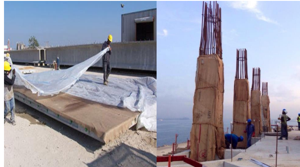
Figuras 4 y 5 Curado de estructuras verticales y horizontales con tela. https://enriquealario.com/curado-de-hormigon/
