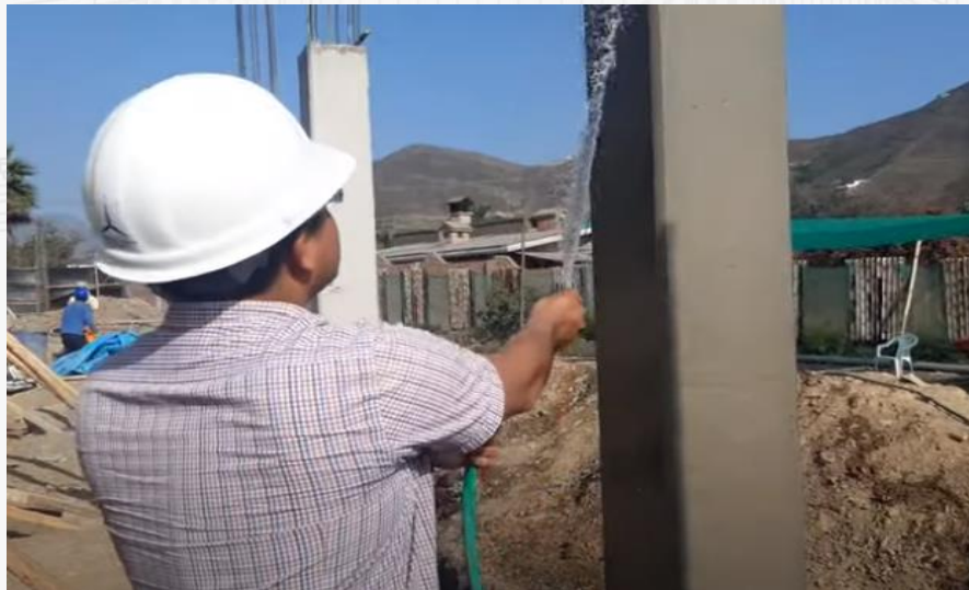
Figura 1. Agua a chorro sobre la columna. https://bit.ly/35GOG5b
