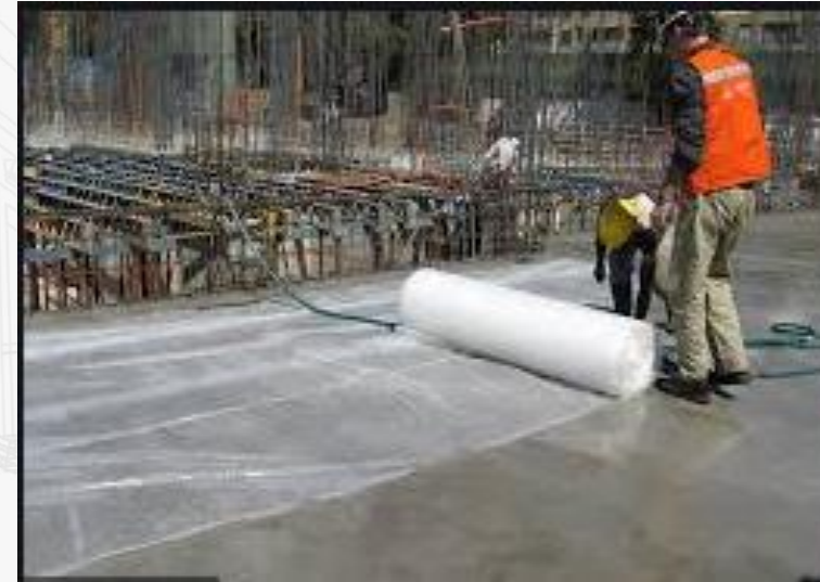
Figura 7. Protección a la evaporización del agua con láminas de plástico. https://bit.ly/2KbDSDz
