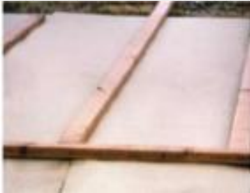
Figura 8. Protección a la evaporización con papel https://bit.ly/3kPDI1j
