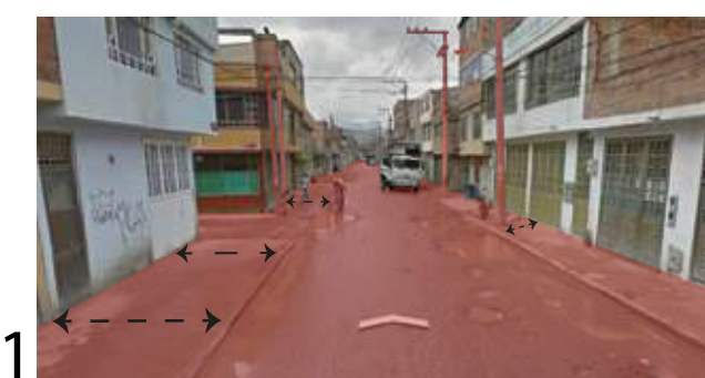
11 Estado de las vías Continuidad de los andenes
