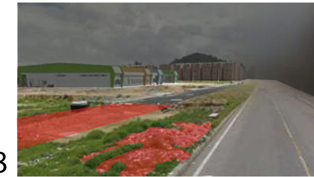
8 Calzada discontinua Escombros y basura en el predio
