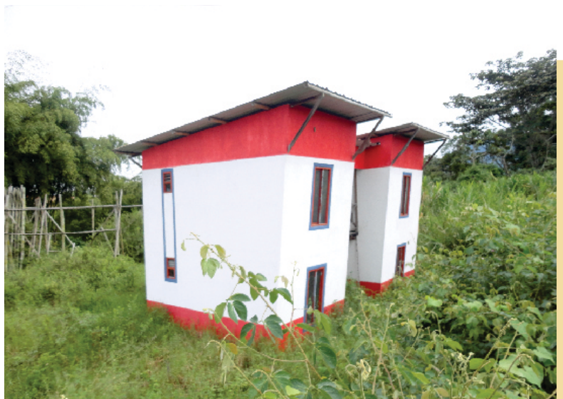
Figura 1: Prototipo de vivienda social en guadua en el municipio de Calarcá Quindío construida en 2012. Fuente: José Alcides Ruiz
