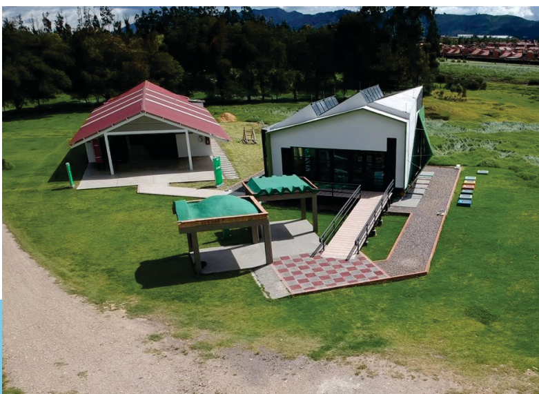
Figura 2: Ubicación del prototipo de Vivienda-laboratorio junto al Domo Sostenible, prototipos de cubiertas alternativas y el Laboratorio de Tierra y Madera. Fuente: José Alcides Ruiz y Luis Gilberto Delgado.
