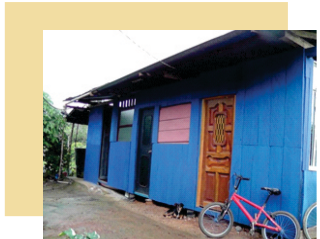
Imagen 1: Cuesta, A (2019) Tipología de viviendas en asentamientos informales rurales, antes de sufrir un proceso de transformación hacia modelos más resistentes y urbanos.
