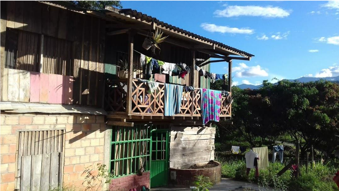
Foto N° 3.: Vivienda típica en el asentamiento Paraíso, municipio de Mocoa. En proceso de transformación con sus materiales en madera y bloques. Fuente propia.
