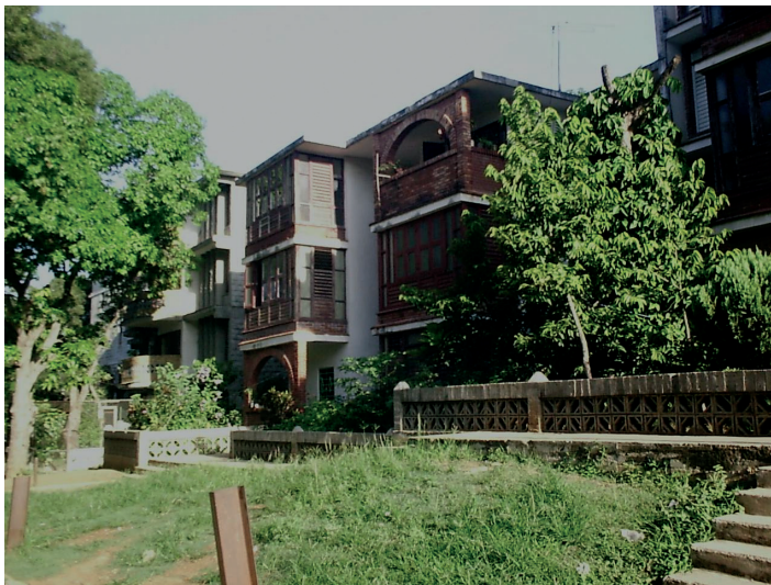
Figura 18. Edificio de viviendas construido por las microbrigadas en Las Arboledas, La Habana (Foto de la autora, 2000).
