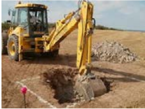
Figura 7. Excavación para cimientos (Arqhys construcciones, 2012).
