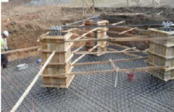
Figura 8. Armado de hierros de una torre y su cimentación (CORIEM, 2011).
