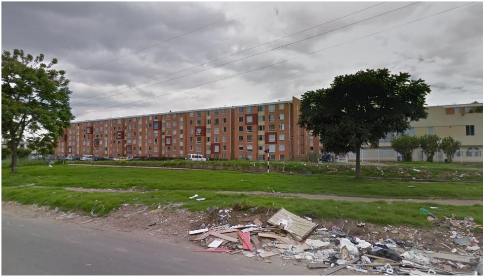
Figura 22. Deterioro urbano. Fuente propia.
