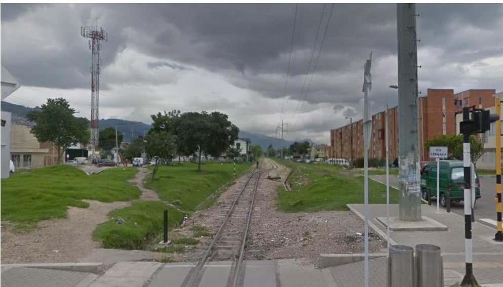
Figura 23. Deterioro urbano. Fuente propia.
