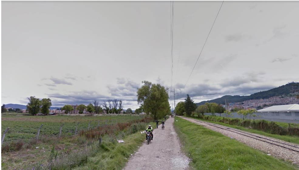
Figura 24. La figura muestra el estado actual de las via ferrea cr9. Fuente propia.
