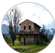
Estación de Ferrocarril Rabanal
