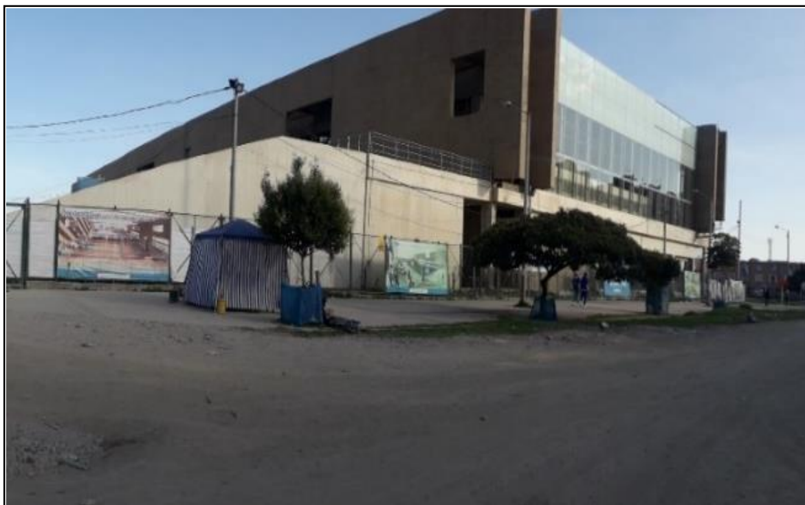
Figura 12 Proceso construcción Centro de Felicidad (actualmente). Elaboración propia
