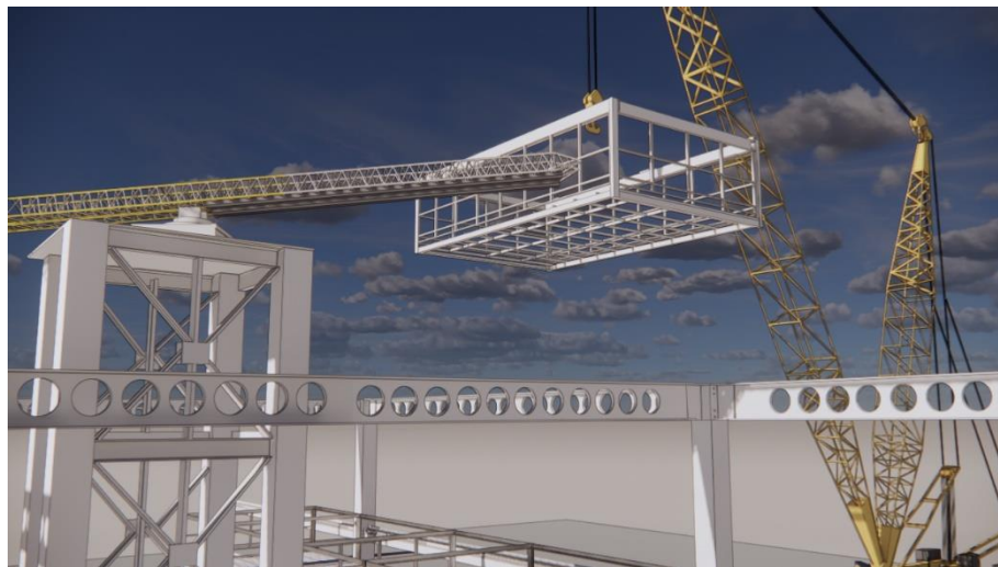
Figura 64 Montaje en sitio con grúa, elaboración propia (2020)
