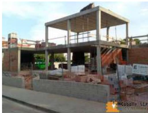
*Figura 25* Estructura de una vivienda de dos pisos. Tomado de “Construcción Casas Y Edificaciones”, Caballé, S.C.P. Construccions, S.F. Recuperado de <http://www.caballeconstruccions.com/obras.php>
