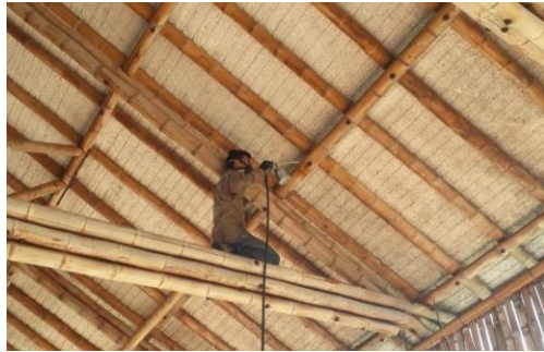
Figura 9 Inyección del preservante (Merulex ® o Lorsban ®) Fuente: Fernando Díaz
