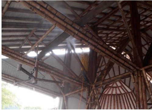
Figura 8 Lavado con hidrolavadora y desengrasante (LPS ®) Fuente: Fernando Díaz
