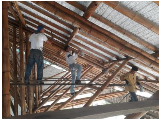
Figura 10 Pintura de la guadua con el lasur o pigmento (Impra ® o Profilan ®) Fuente: Fernando Díaz
